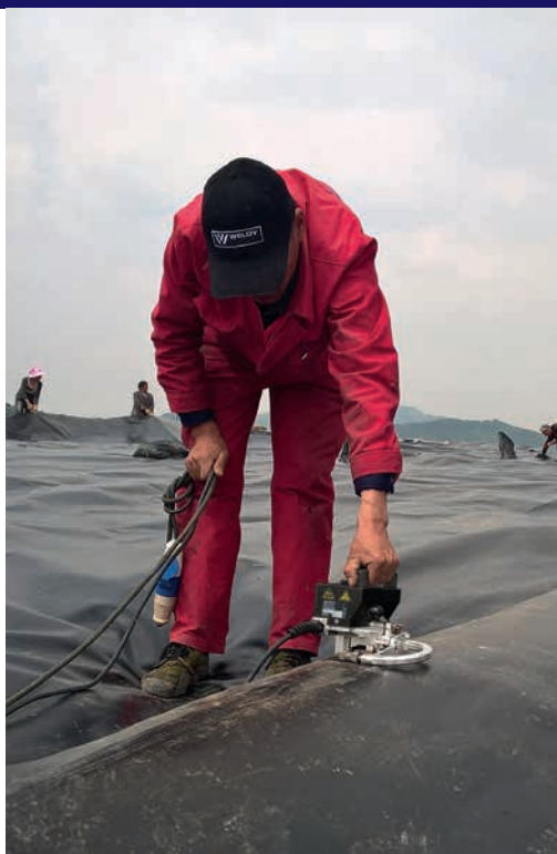
156.617 (230 V) 热楔, 56 x 36 mm, 铜 质, 带测试通道
