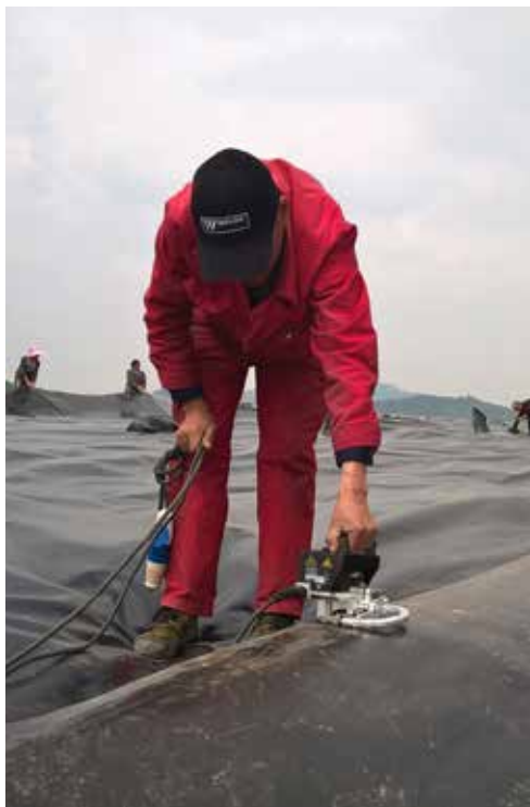
156.617 (230 V) 热楔, 56 × 36 mm, 铜 质, 带测试通道
