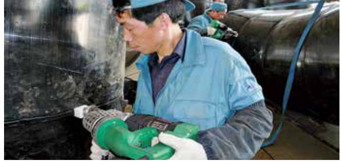
中国的客户使用 FUSION 2 焊接化工储槽。
