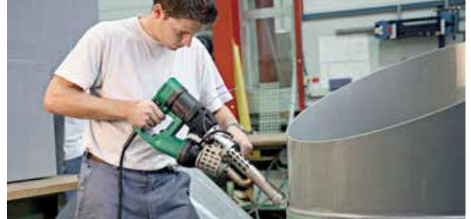
使用 FUSION 3C 焊接 V 型焊缝。
